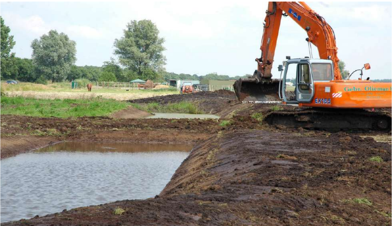
Figuur 10: Graven van een watergang
