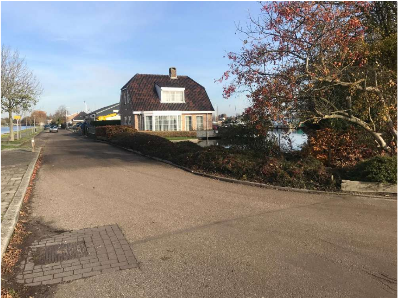
De brug lag op deze locatie waar de Reewetering in verbinding stond met de Breevaart.
