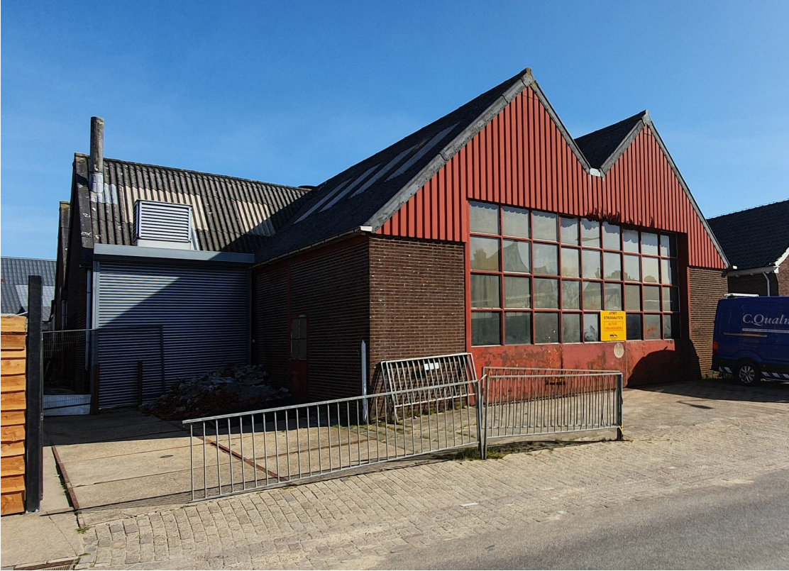
De oude loods met enkelvoudig golfplaten dak. Foto. K. de Vries | Ecoresult BV
