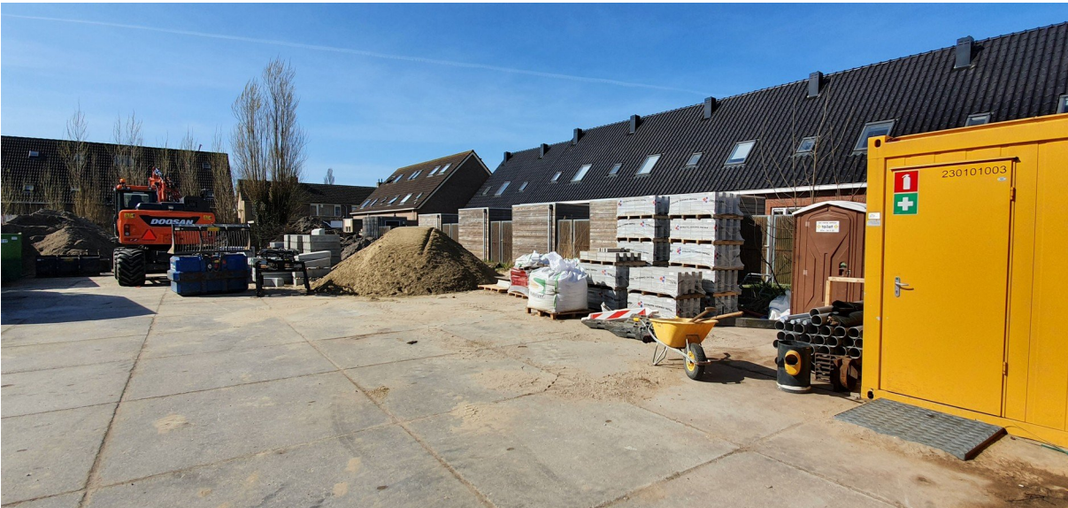
Het opslagterrein wordt door aannemers gebruikt voor opslag van materialen, zand en aarde. Foto. K. de Vries | Ecoresult BV
