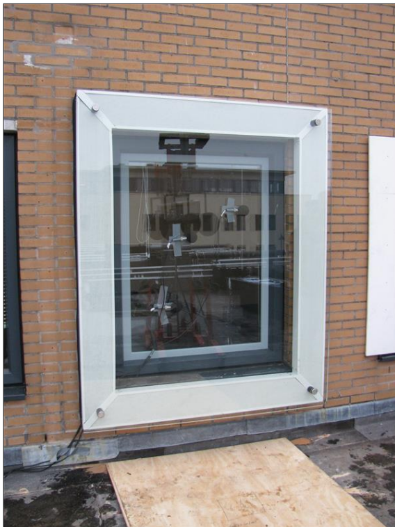
Foto II.3 Aanzicht glazen gevelgeluidscherm
