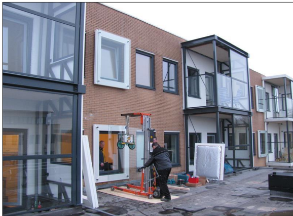
Foto II.1 Aanzicht glazen gevelgeluidschermen
