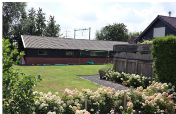
Een te handhaven bijgebouw op het achtererf.
