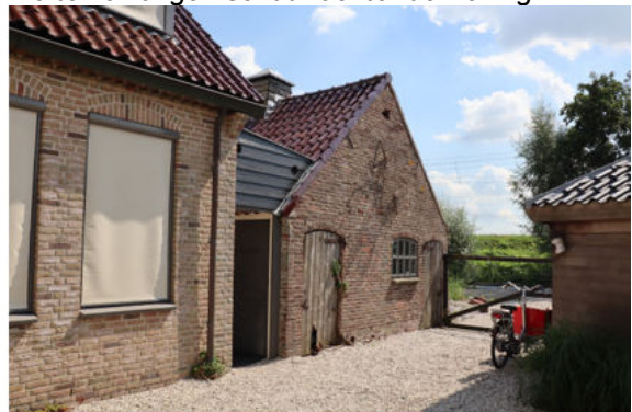
De te vervangen schuur achter de woning.
