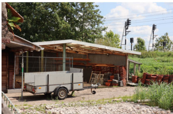
De te slopen schuur van 90 m 2 op het achtererf.
