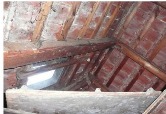
Onderzijde niet afgewerkt dak.
