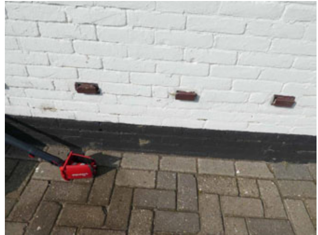
Figuur 11: ventilatiegaten aan de onderkant van de muur
