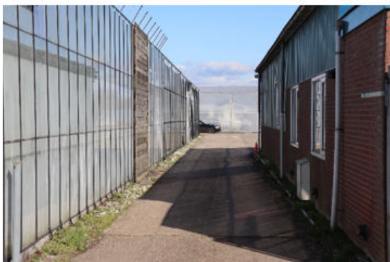
Links kassen en rechts de bedrijfsloods.
