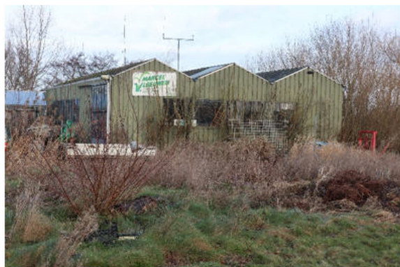
Te slopen loods waar woning is gepland.
