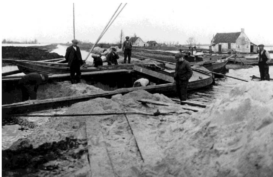
Afbeelding 4: Winter 1926, herstelwerkzaamheden aan de dijkdoorbraak in de Lecksdijk. Op de achtergrond het open landschap rond plas Gravekoop.
