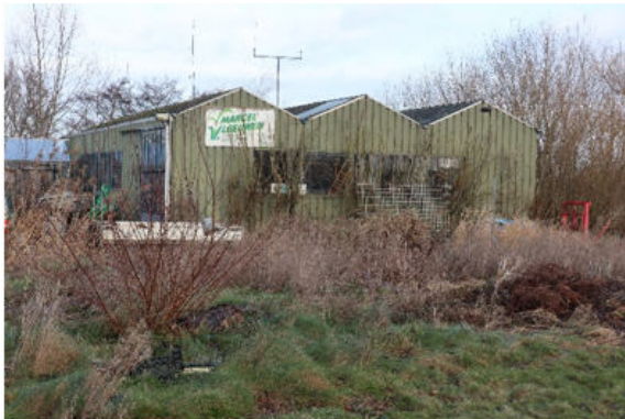
Te slopen loods waar woning is gepland.
