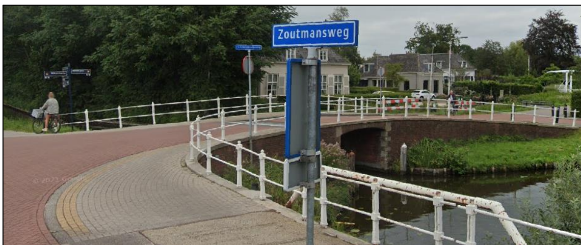
Figuur 4: Brug 's-Gravenbroekse weg, richting Reeuwijk (ten noorden van plangebied) – Google Streetview
