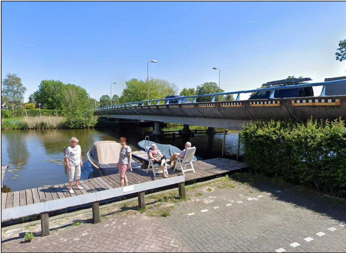
Figuur 5: Brug Goudse Houtsingel, richting Gouda (ten zuiden van plangebied) – Google Streetview
