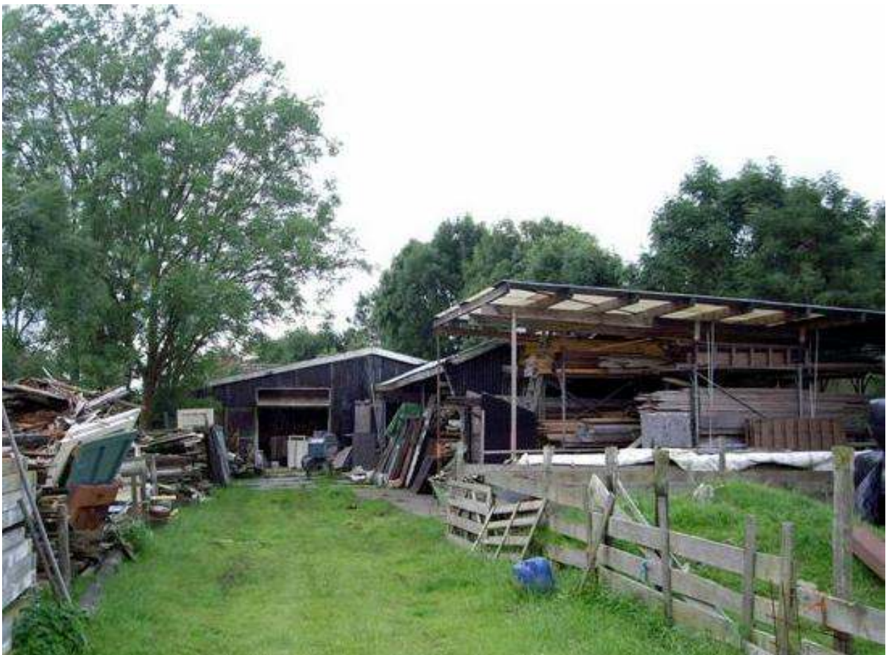
Figuur 5: De af te breken houten loodsen en stelling voor houtopslag aan de westkant van het erf.
