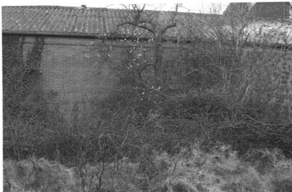
Figuur 4: Zicht op de westzijde van de planlocatie.
